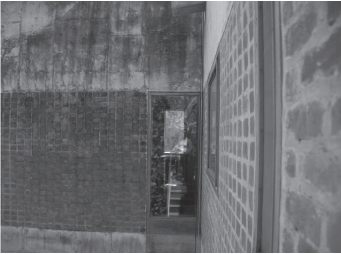
F6—Sharabai. Vista exterior. Diferente aparejo del ladrillo en los paños entre ventanas. Foto: A. M. Castillo
