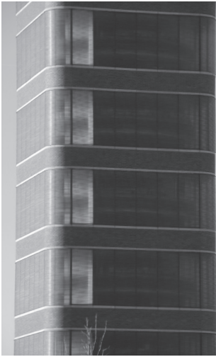
F7—Edificio Johnson. Fragmento de la torre de laboratorios.
