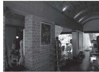
F3—Villa Sharabai. Proyecto inicial de noviembre de 1952. Las bóvedas de ladrillo se reflejan en la fachada exterior
