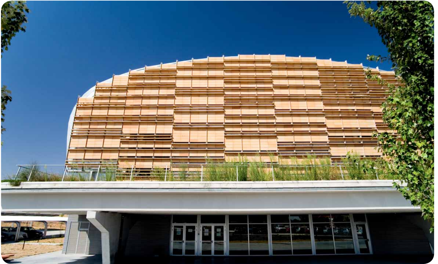
En el diseño del edificio se fusiona la forma arquitectónica con el funcionamiento bioclimático.
