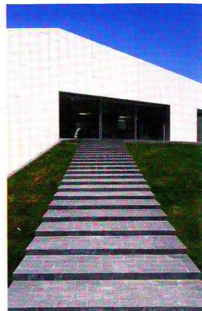
In queste pagine: la Casa Ubiñana a Sant Cugat del Vallès (2008). La facciata ventilata e il tetto sono interamente rivestiti da piastrelle di porcellana dura da 45 x 90 cm, con un fissaggio invisibile; la mancanza di fenditure permette di attutire l'inquinamento acustico.
